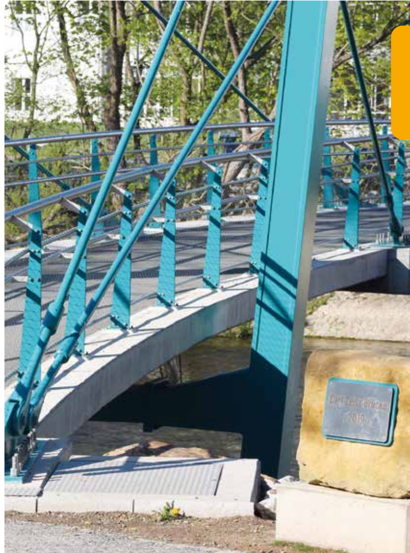
Foto: M. Modes | Die neue Carl-Zeiss-Brücke über die Saale in Saalfeld
